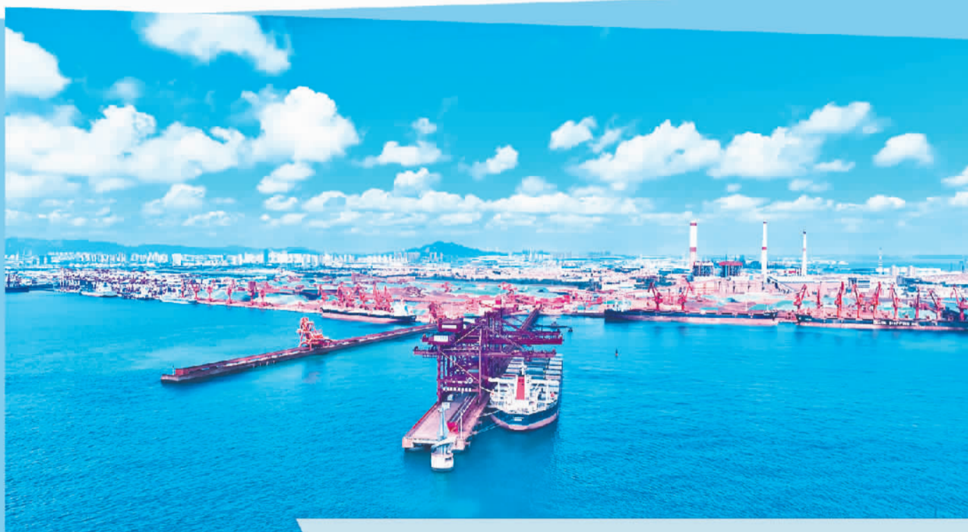
山东港口青岛港是全国首批、港口行业唯一的交通领域国家人工智能应用中试基地,图为20万吨级矿石码头正在进行卸船作业。 王廷军摄
