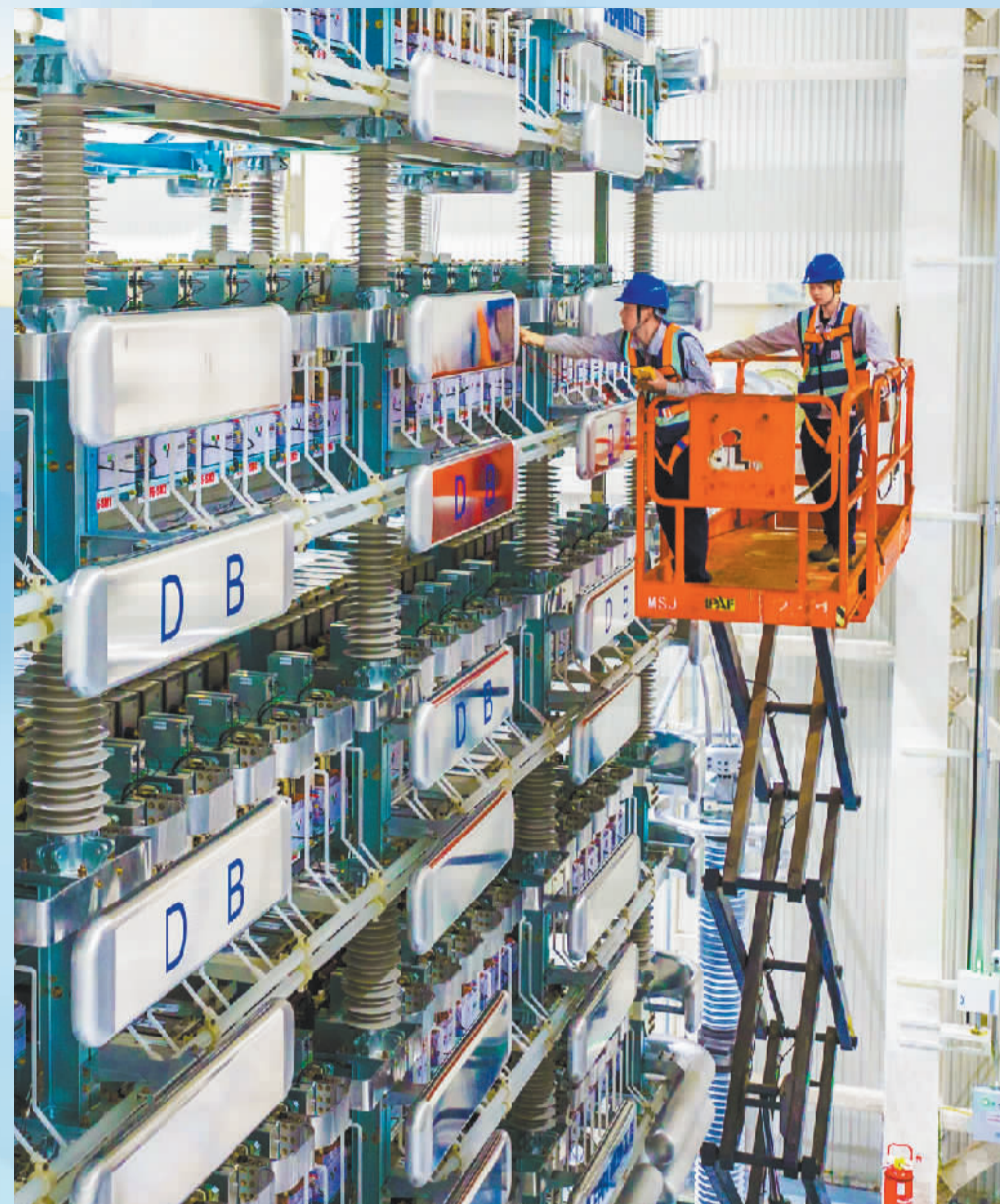
▲5月11日,江苏省苏州市±800千伏姑苏换流站,工作人员在检修设备。该换流站是“西电东送”工程的重要组成部分。 史俊摄(中经视觉)
