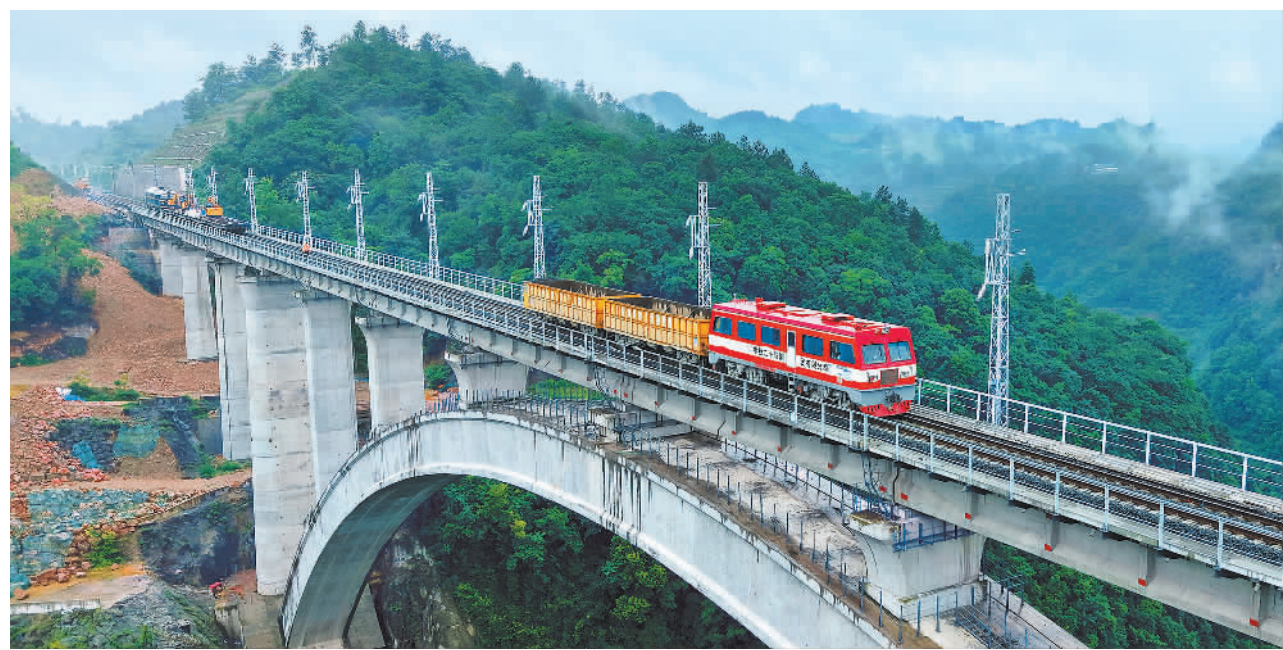
5月29日,施工车辆从贵州瓮马铁路南北延伸线板布河大桥上通过。当日,由中铁二十局承建的贵州瓮马铁路南北延伸线瓮安至天文段长轨铺设作业全部完成,顺利贯通,为北延伸线通车奠定坚实基础。 本报记者 吴秉洋摄
