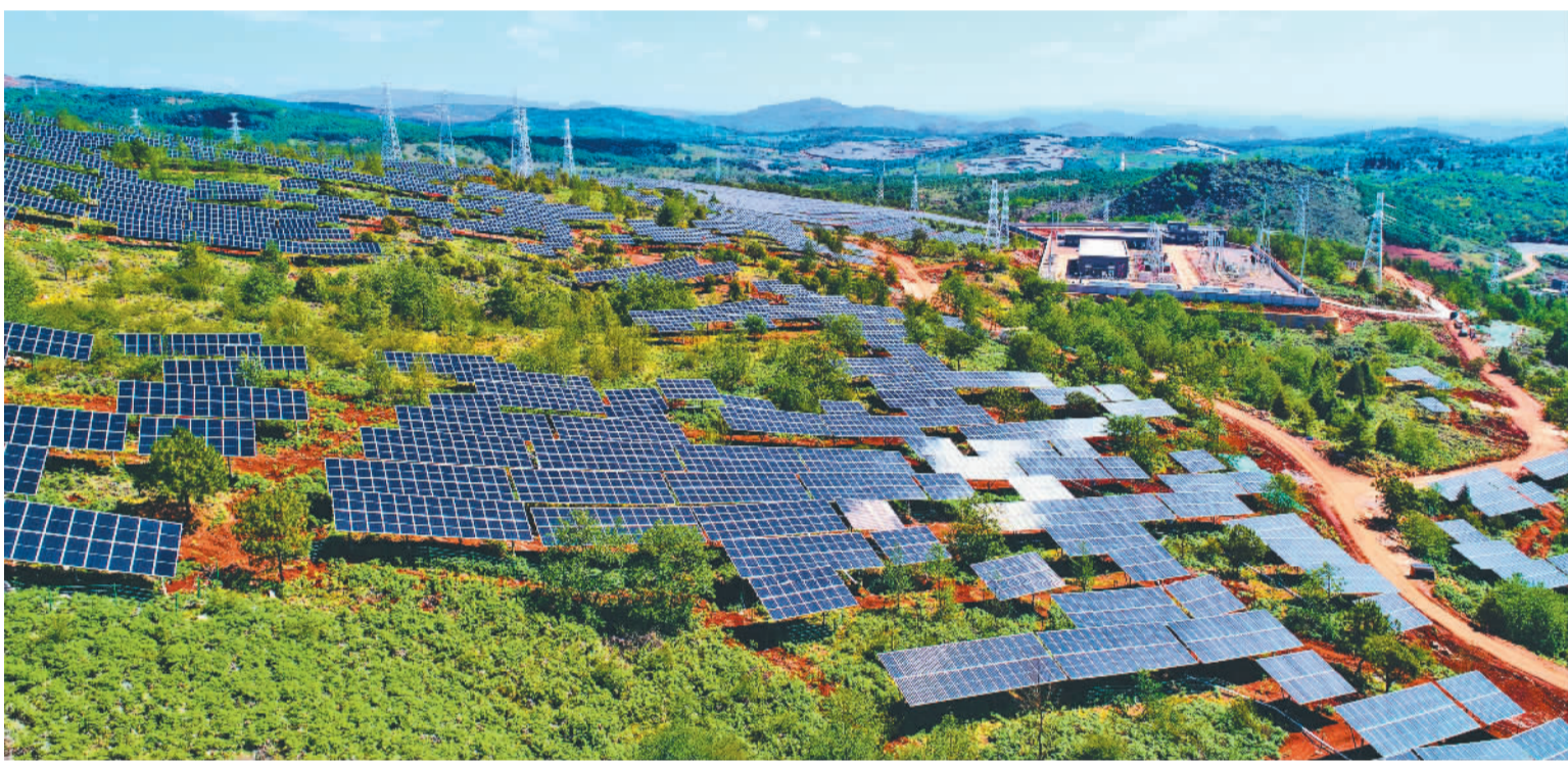
近日，昆明寻甸竹园沟光伏发电项目新增光伏阵列并网投产，云南省新能源装机突破8000万千瓦。近年来，为确保千万千瓦级新能源项目“接得住、送得出、用得好”，南方电网云南电网公司持续推进新能源配套接网工程、配套间隔工程建设。杨 勇摄（中经视觉）
