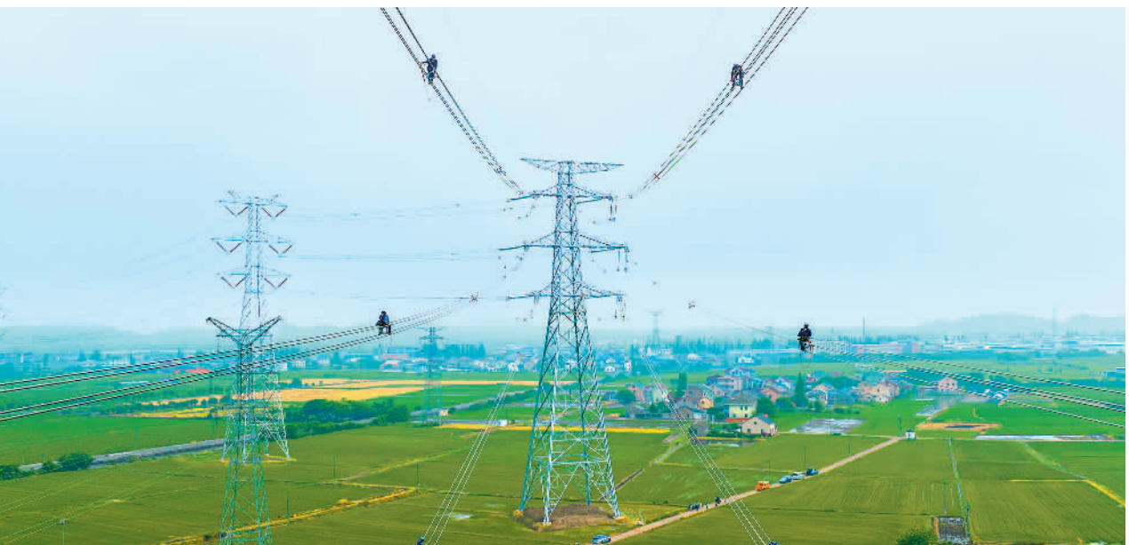
5月22日，甘肃—浙江±800千伏特高压直流输电工程受端500千伏配套工程迎来关键节点，首条送出线路——换流站—春晖双回、换流站—明州双回500千伏线路全线贯通。线路投运后，将进一步增强输出地电网支撑能力。徐 昱摄（中经视觉）
