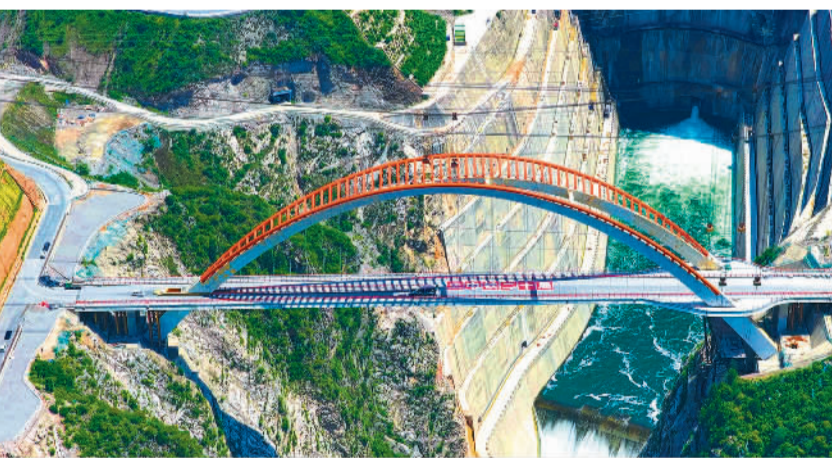
5月21日，由中铁二十局承建的陕西东庄水利枢纽泾河大桥完工。该桥全长284米，是国内首例中承式空间Y型钢箱拱桥。王凯强摄(新华社发)
