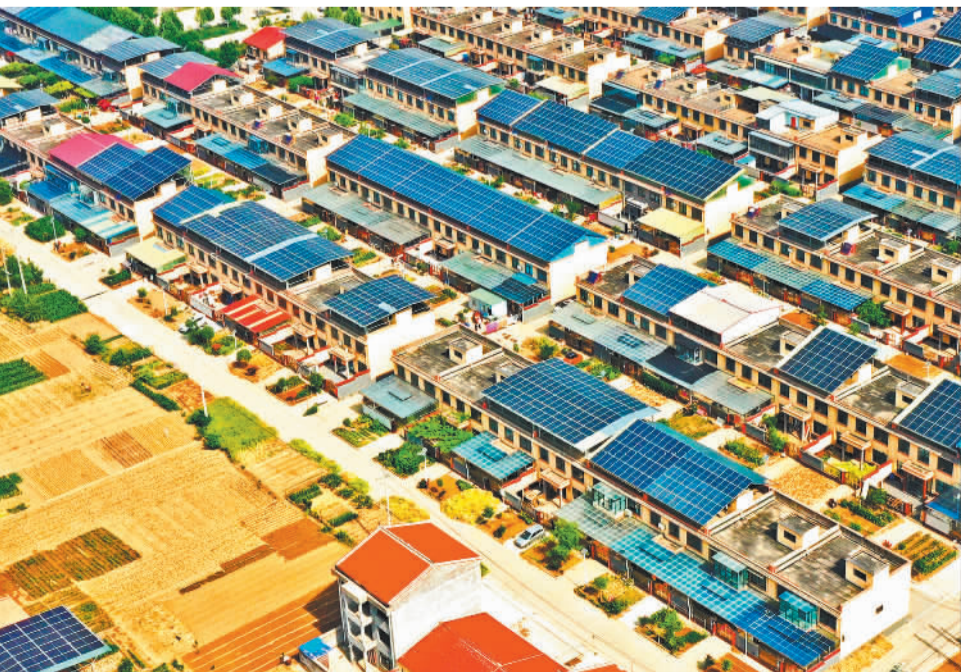
5月11日，河南省孟州市西魏镇义井村新区，农户屋顶上光伏板整齐排列、熠熠生辉。近年来，当地坚持生态优先发展理念，大力推广光伏发电等清洁能源，引导绿色发展、绿色生活。白水平摄(中经视觉)
