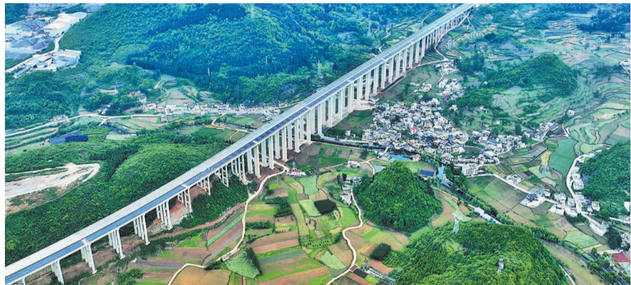
日前，贵州乌当(羊昌)至长顺高速公路主线全线贯通，通车后将作为连接贵阳与黔南、黔东南地区的重要交通动脉。这是5月10日拍摄的乌长高速公路文昌宫特大桥。
