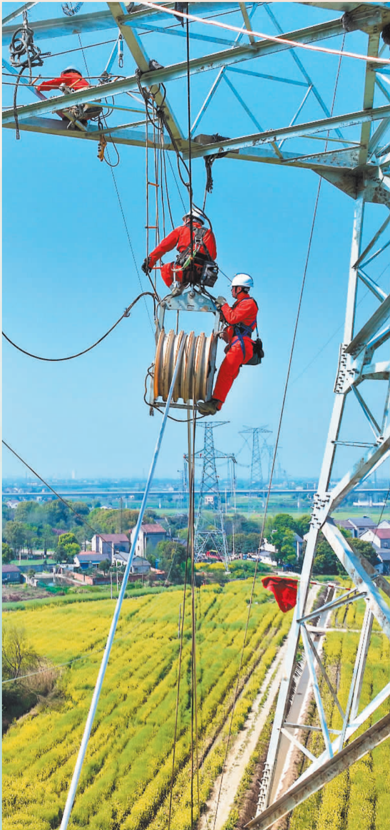
►4月1日,湖北省荆州市八岭山镇,国网湖北超高压公司员工对三峡水电送往广东的±500千伏江城线18号至19号塔开展过改施工。 孔轲摄(中经视觉)
