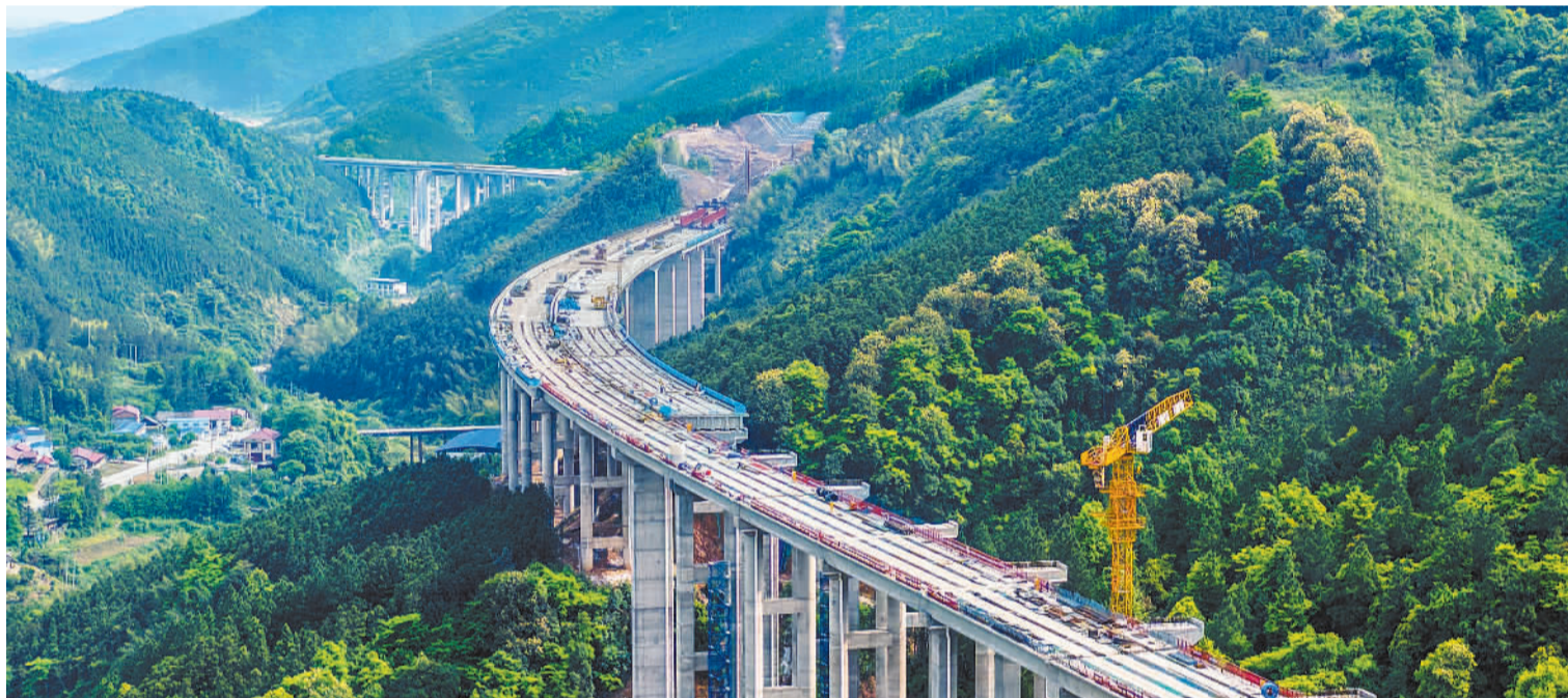
4月25日，工人在湖南省永州市双牌县零(陵)道(县)高速建设现场进行施工作业。项目建成后，可有效改善湘南山区交通状况，促进区域社会经济协调发展和产业升级。
