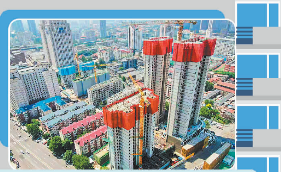
因为天津市和平区的中铁建工集团和平区大沽北路A地块项目外幕墙低噪声施工现场。罗丽椒摄(中经视觉)
