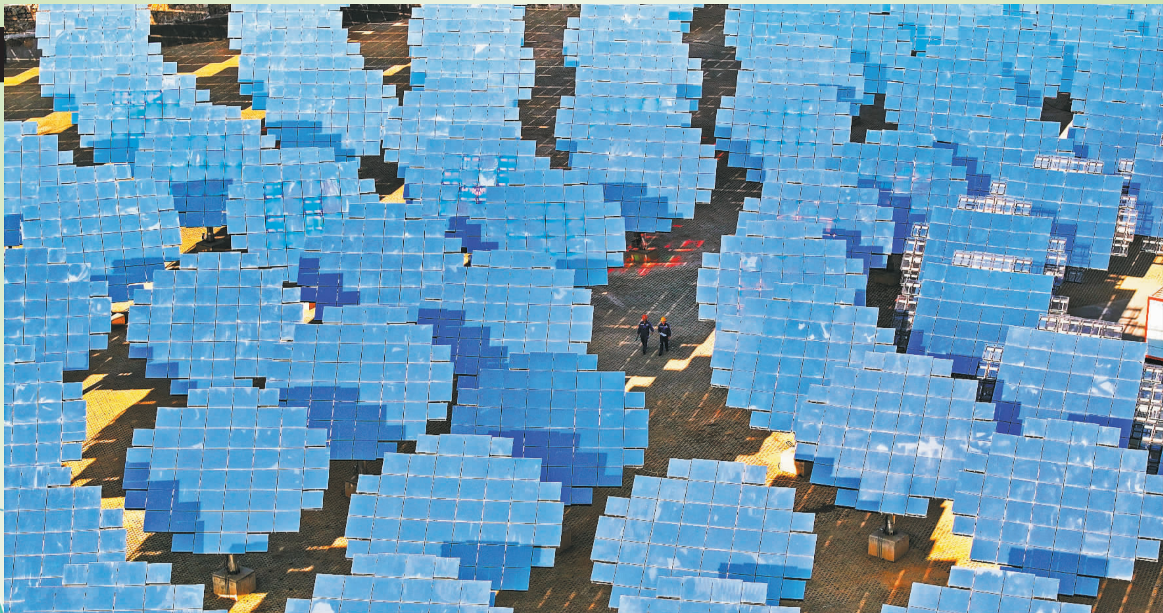
▲3月24日,位于四川省攀枝花市西区的多面体钛酸银聚光制氢(加氢)一体站中试基地,工作人员在巡检多边形定日镜。这是我国首条光解水制氢生产线,产出氢气纯度可达99.9%。李向雨摄(中经视觉)
