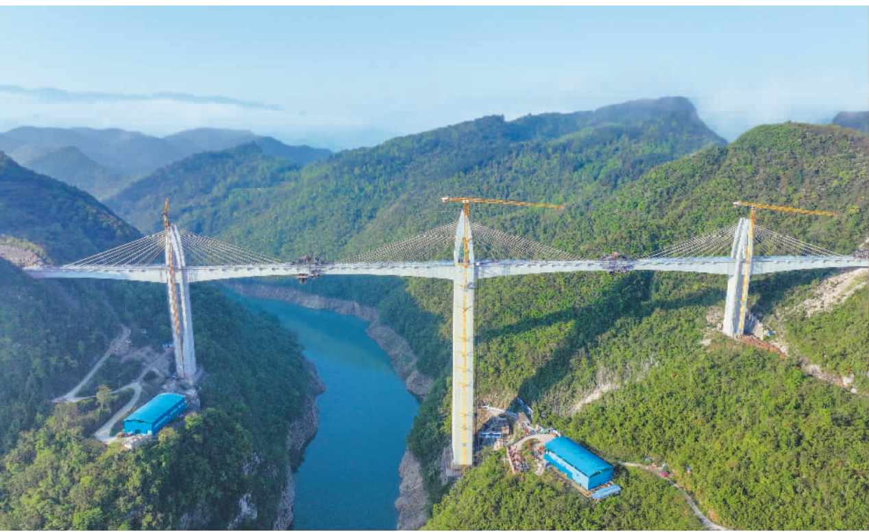
4月4日拍摄的贵州瓮马铁路南北延伸线湘江特大桥项目施工现场。该大桥位于贵州省黔南布依族苗族自治州瓮安县和遵义市播州区交界处，瓮马铁路南北延伸线建成后，将衔接川黔、沪昆、黔桂铁路，成为西部陆海新通道重要组成部分。 袁福洪摄(中经视觉)
