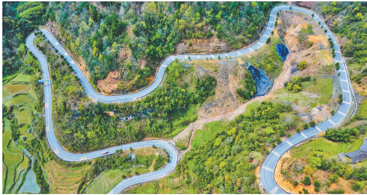
近年来，贵州省黔东南苗族侗族自治州岑巩县加大基础设施建设力度，坚持把“四好农村路”建设与发展地方特色农业、乡村旅游产业等紧密结合，努力实现公路畅、产业兴，助力当地乡村全面振兴。图为岑巩县客楼镇公路一段。胡国鑫摄(中经视觉)
