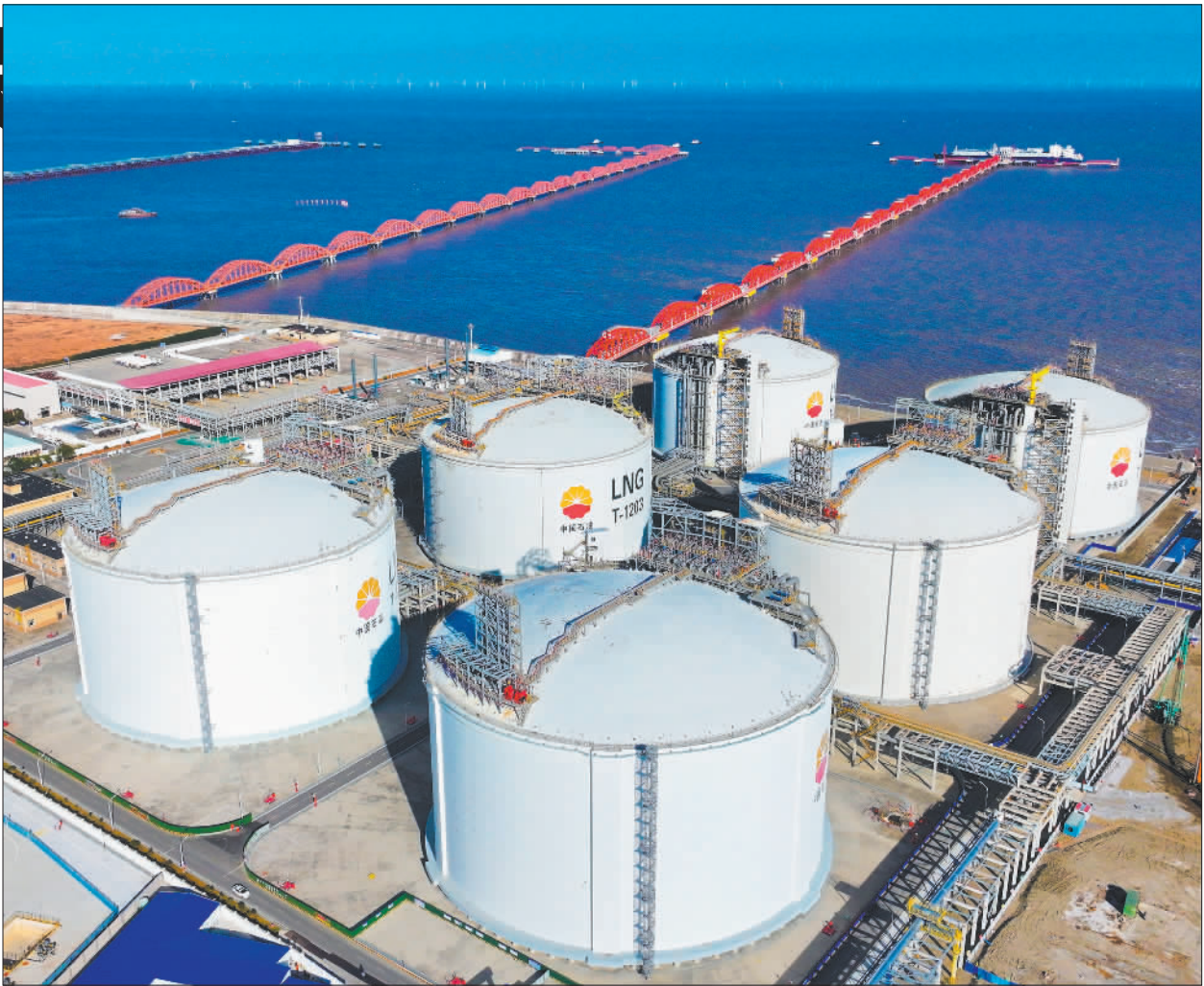
▲2025年12月31日拍摄的江苏省南通市如东县中石油江苏LNG接收站全景。该站现有6座LNG储罐,冬季保供关键时期单日最高外输气量可达4200万立方米。 徐书影摄(中经视觉)
