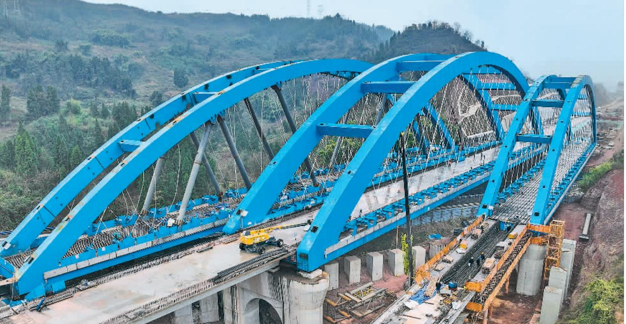
1月22日拍摄的正在建设中的西渝高铁跨营达高速公路大桥。当日,由中铁四局承建的西渝高铁跨营达高速公路大桥右联平稳落在桥墩上,标志全国首座高铁大跨度网状吊杆系杆拱桥全桥顶推完工,为全线按期通车奠定了基础。新华社记者 王曦摄
