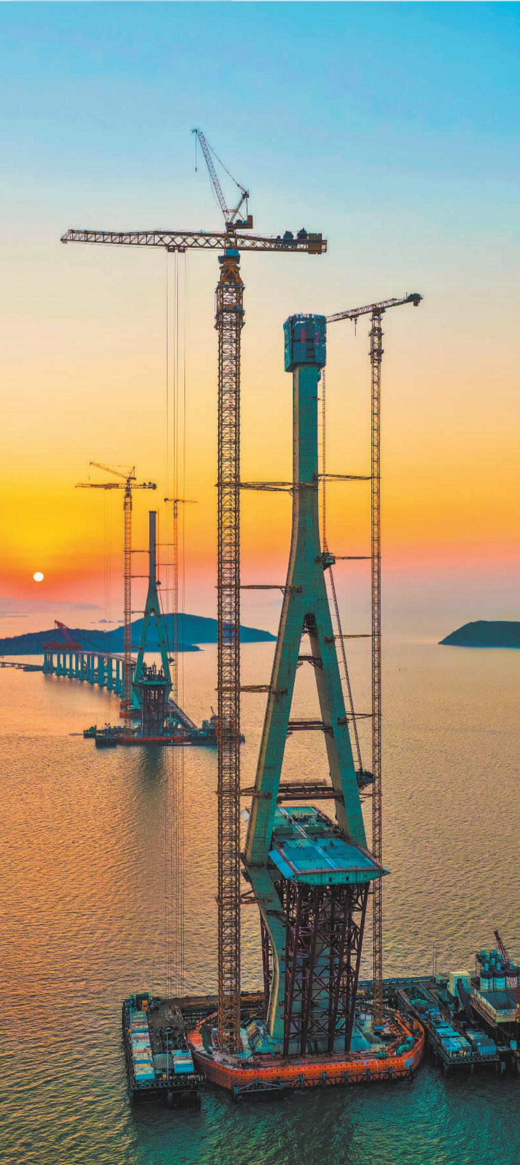
▲1月13日,位于浙江省宁波市舟山港的青龙门特大桥Q4主塔完成封顶。该桥是宁波舟山港六横公路大桥二期工程控制性工程之一,连接宁波梅山岛与舟山佛渡岛,是世界最大跨度三塔钢箱梁斜拉桥。
