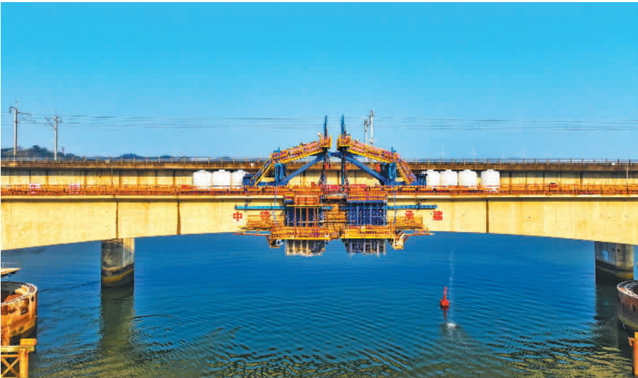
1月13日,南防铁路钦州至防城港段增建二线工程茅岭江特大桥连续梁主跨顺利合龙。南防铁路钦州至防城港段增建二线工程正线全长53.33公里,项目建成通车后,将有效提升广西铁路出海大通道运输能力,改善北部湾地区港口集疏运条件,对促进区域协调发展具有重要意义。
