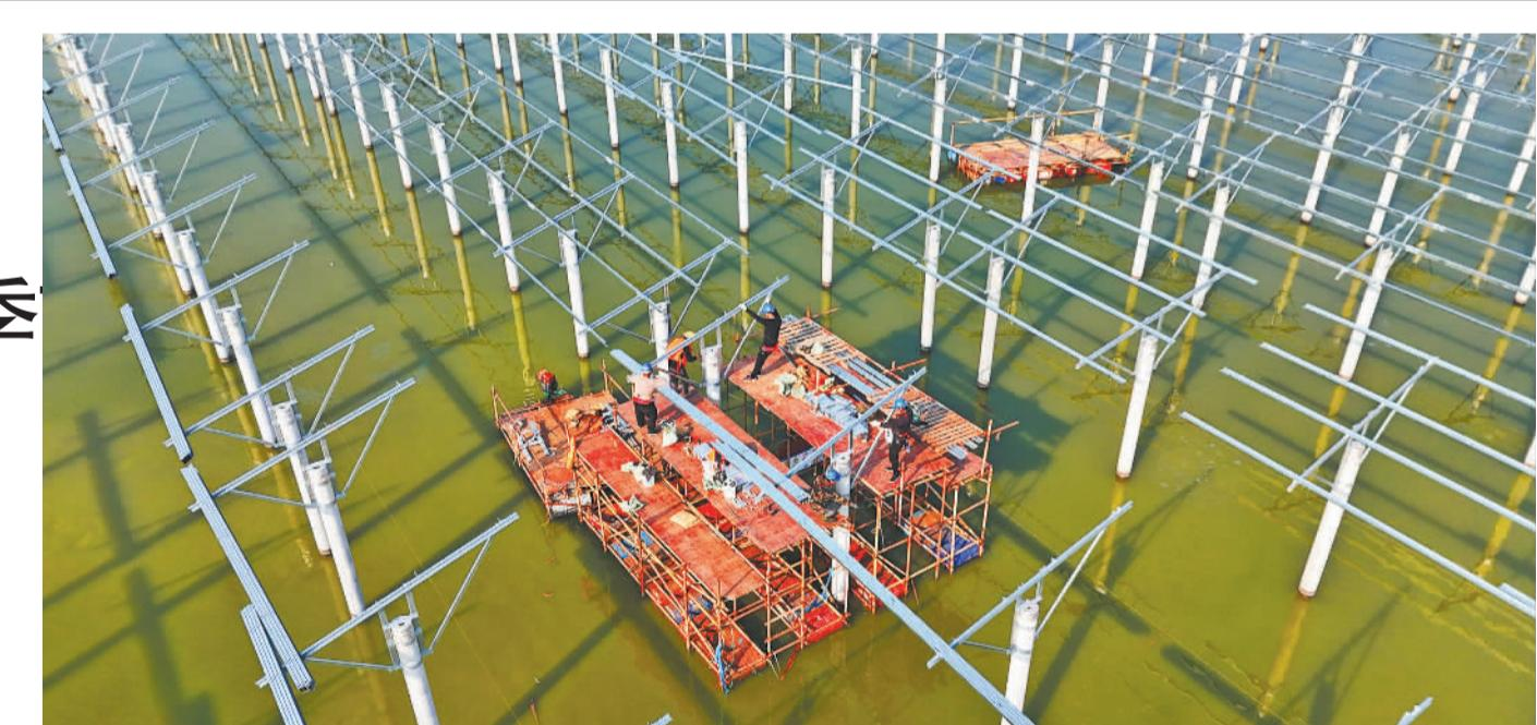
1月7日,江苏省连云港市海州区浦南镇,工人在渔光互补光伏发电项目施工现场进行设备安装作业。近年来,海州区通过渔光互补、农光互补等模式,加速推进光伏项目建设,经济效益与生态效益同步提升。
