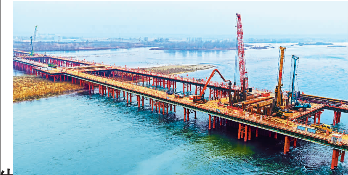
1月3日,河南省洛阳市孟津区,呼(呼和浩特)南(南宁)高铁焦济洛平段洛阳黄河公铁大桥建设者正在施工。作为项目重要节点,洛阳黄河公铁大桥全长13.36公里,采用双层公铁两用结构,建成后对促进当地经济社会高质量发展、加快融入中部地区崛起战略具有重要意义。 白水平摄(中经视觉)
