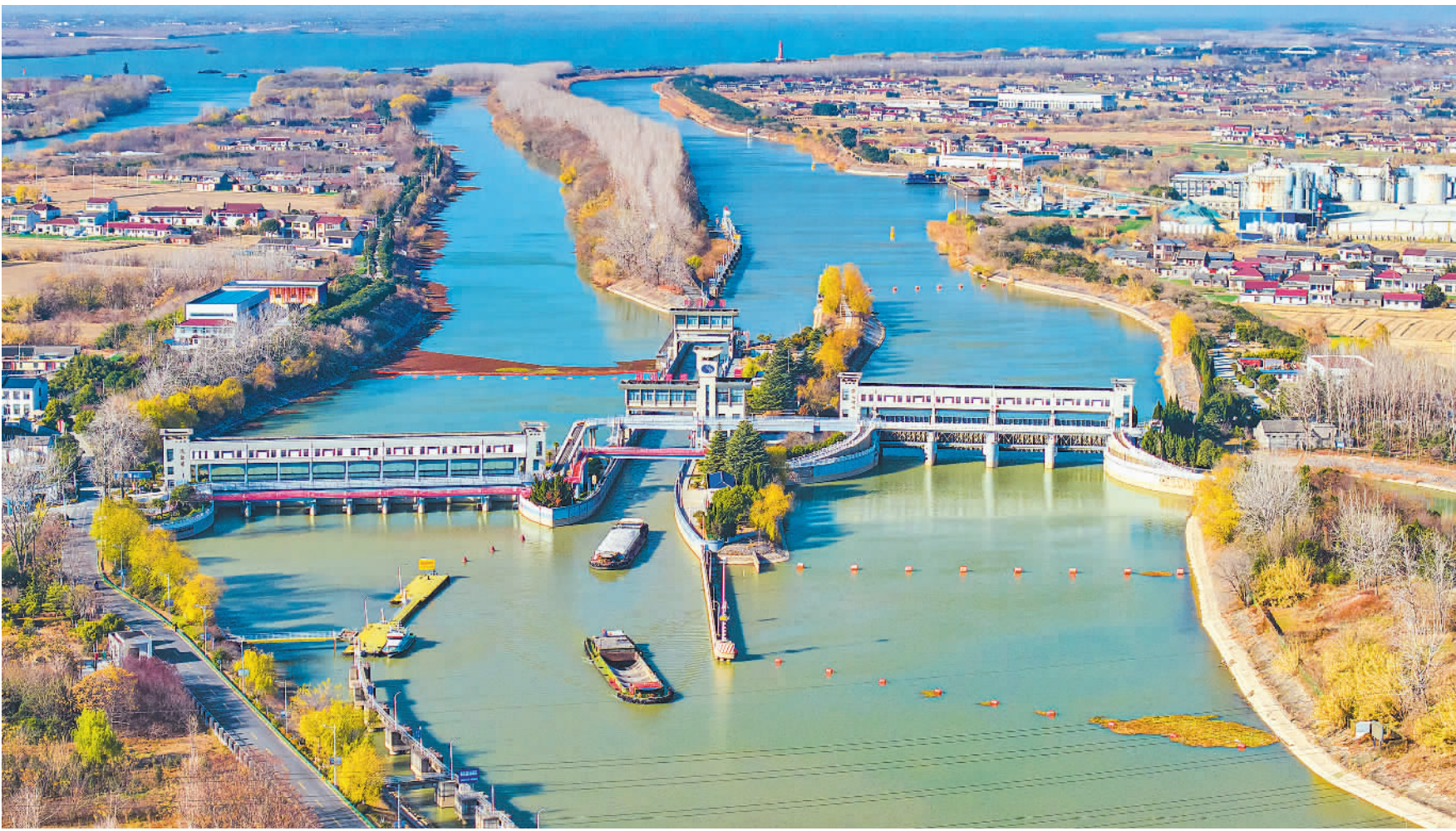
12月21日在江苏省扬州市江都区拍摄的南水北调东线一期工程运盐闸、邵仙套闸、邵仙闸洞。“十四五”期间，南水北调东线一期工程连续5年顺利完成冰期输水任务，累计冰期调水约9.61亿立方米，有力确保极端寒潮天气下的供水稳定，精准保障沿线地区生活、工业、农业及生态等用水需求。
