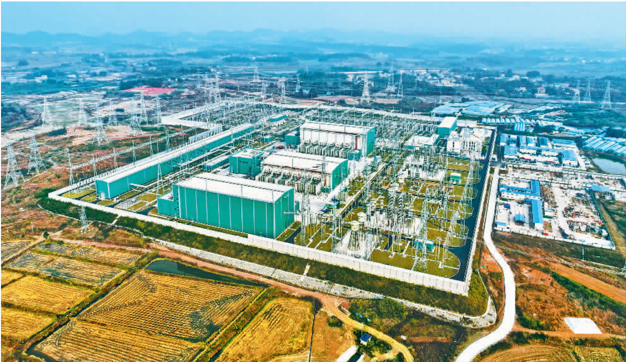
12月18日,金上一湖北±800千伏特高压直流输电工程全面建成投产。该工程是我国“西电东送”工程的重要组成部分,每年可向华中地区输送清洁能源近400亿千瓦时。图为位于湖北黄石的大冶±800千伏换流站。 高梦露摄(中经视觉)
