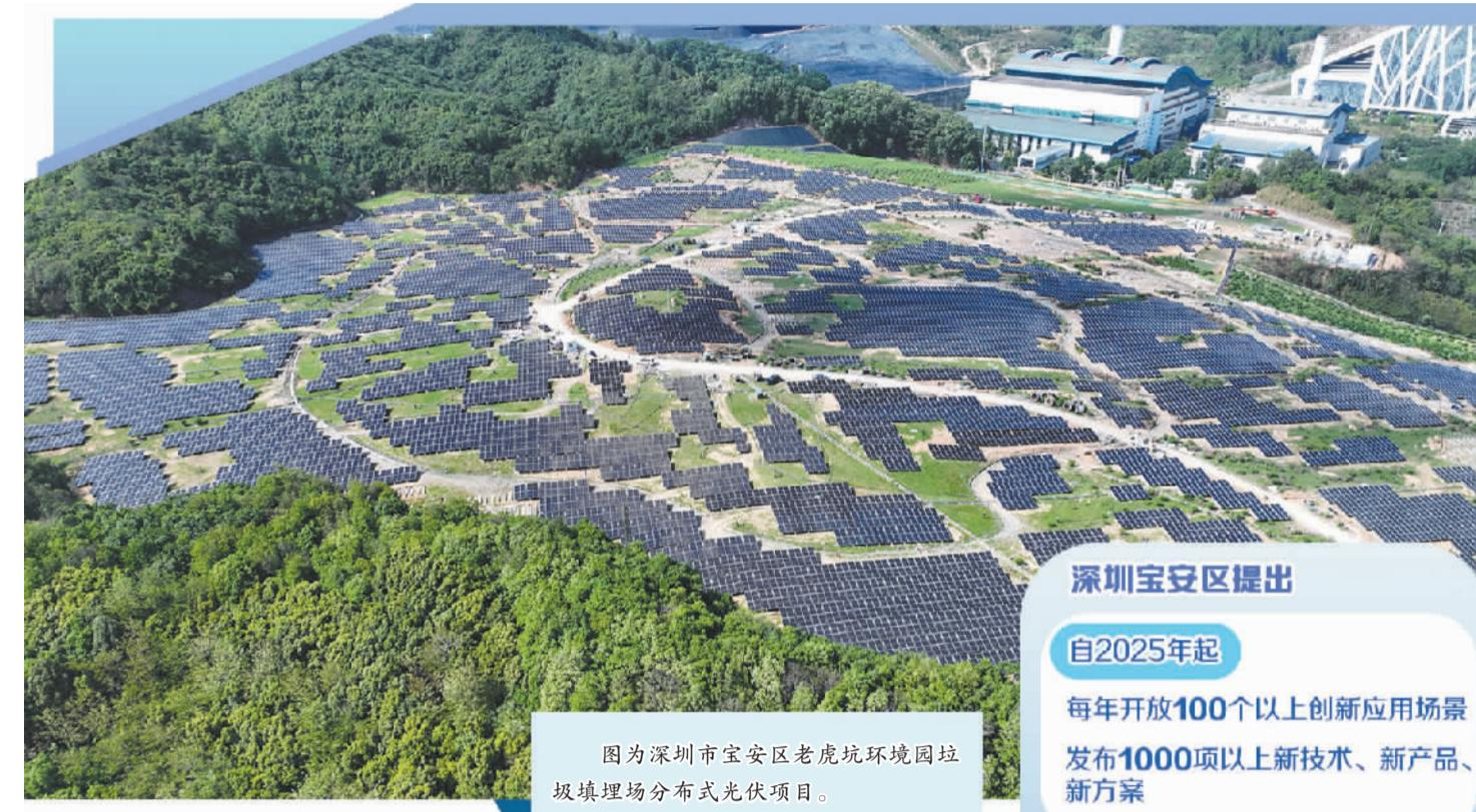
图为深圳市宝安区老虎坑环境园垃圾填埋场分布式光伏项目。
