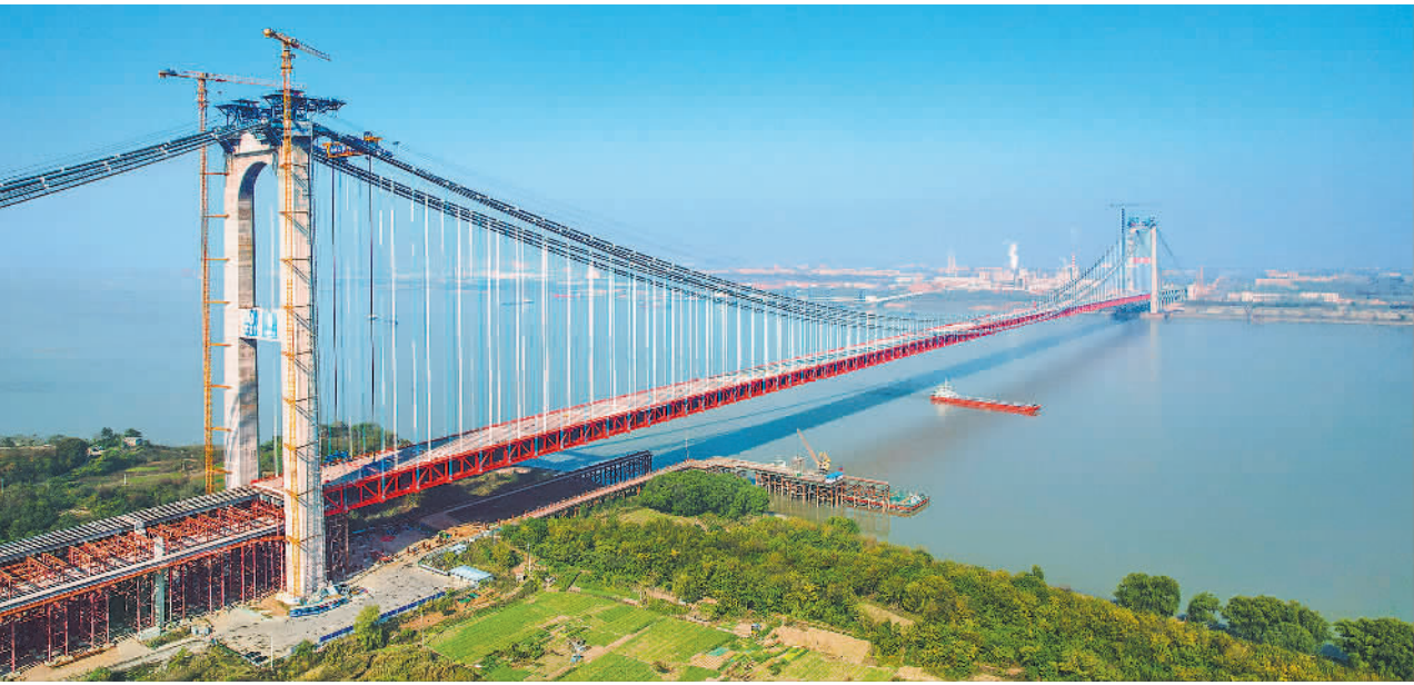
11月22日,湖北蕲阳长江大桥顺利合龙。该大桥横跨湖北鄂州、黄冈两地,是世界最大跨径四主缆悬索桥。大桥建成后,将进一步完善区域“公、铁、水、空”综合交通运输体系,为区域经济社会发展注入新动能。 薛 婷摄(中经视觉)
