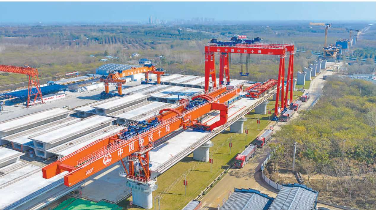
近日,合(肥)武(汉)高铁安徽段全面进入箱梁架设阶段,施工人员奋战在架梁一线,确保重点铁路工程建设进展顺利。这是11月15日拍摄的合武高铁安徽段站前一标肥西制梁场首榀箱梁架设现场(无人机照片)。 刘玉才摄(新华社发)
