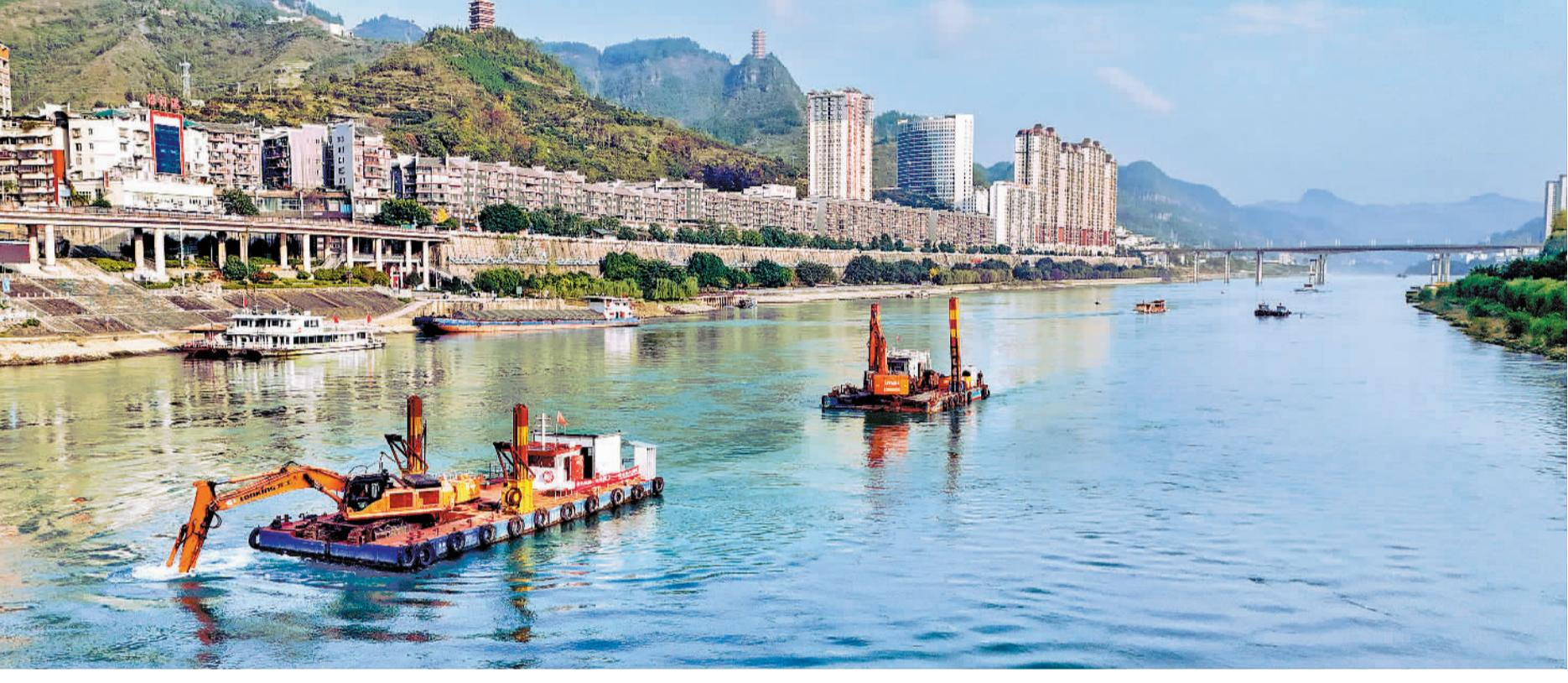
11月15日，贵州省铜仁市沿河县乌江江面，施工船正进行航运扩能作业。乌江航运扩能项目重点整治构皮滩、沙沱及彭水水库区变动回水段，包含疏浚、炸礁、清礁、锚地、桥梁改建和航道信息化等工程，计划3年完成。
