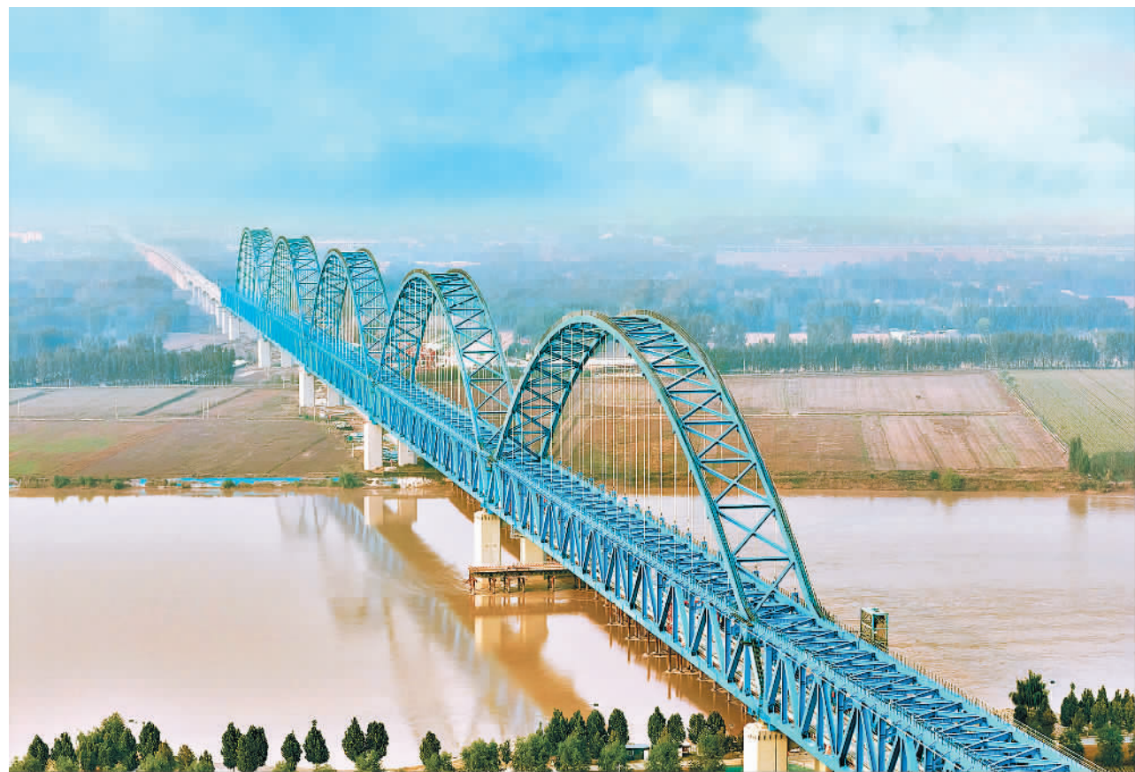
10月24日,随着最后一块无砟轨道板顺利铺设浇筑,京港高铁雄安段黄河特大桥无砟轨道工程全部完工,为后续铺轨作业顺利开展奠定了基础。该大桥位于山东省梁山县与河南省台前县之间,采用“一联九跨”连续钢桁梁结构,具有长联、大跨、高速、无砟的特点,在高速铁路无砟轨道桥梁施工领域处于行业领先水平。 史家民摄(中经视觉)
