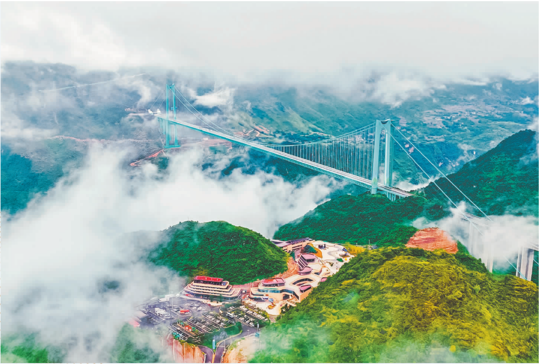
◀9月28日拍摄的花江峡谷大桥。该大桥主缆内置光纤光栅传感器，可实时监测主缆的应力、温度与湿度等数据。
