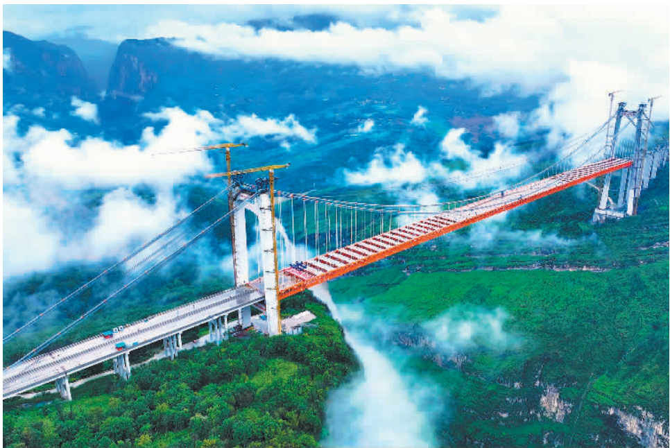
近日,由中铁广州工程局集团承建的贵州安(顺)盘(州)高速公路天门特大桥顺利合龙。天门特大桥是安盘高速公路的重要控制性工程,位于贵州省六盘水市水城区境内,横跨北盘江大峡谷,全长1553米,桥面至峡谷水面高度为560米。 本报记者 吴秉泽摄
