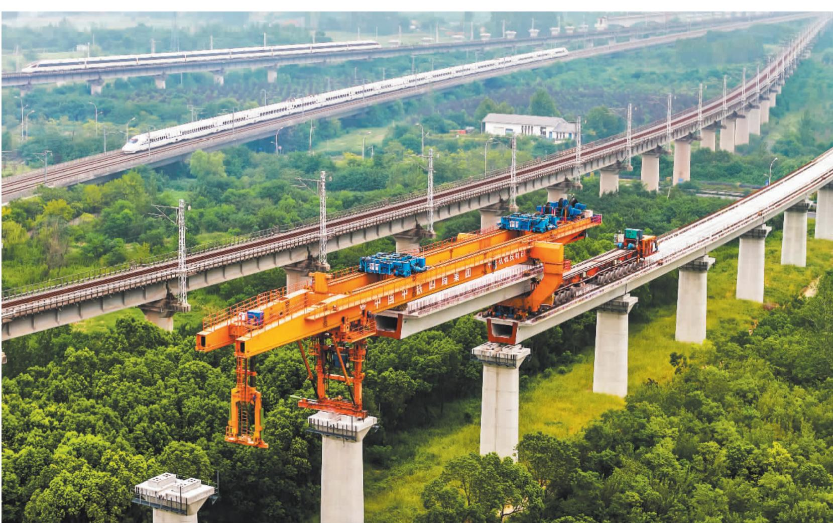
▲9月6日,安徽省合肥市新建上海至南京至合肥高速铁路沪宁段站前Ⅱ标施工现场,技术人员在进行预制箱梁架设作业。
