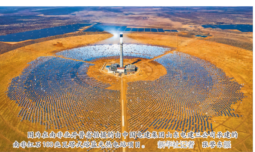
因为在南非北开普省拍摄的由中国电建集团山东电建三公司承建的南非红石100兆瓦塔式熔盐光热电站项目。 新华社记者 张琴东 摄
