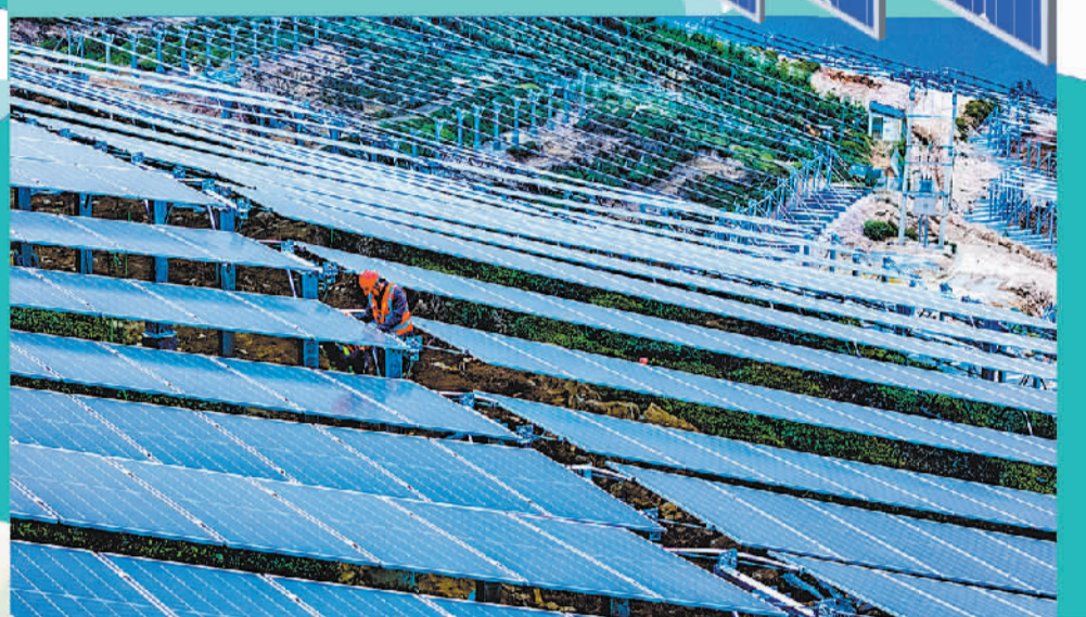
技术人员在湖北省宜昌市秭归县茅坪镇四溪村光伏电站建设现场安装光伏板。彭 强摄(中经视觉)
