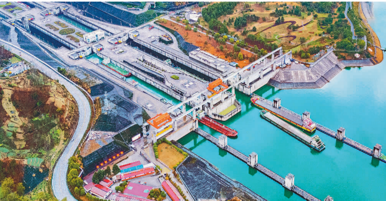
1月25日，货运船舶行驶在三峡船闸。春节临近，为保障坝区水域交通平稳有序，长江三峡通航管理局发布通告，从1月23日9时起至1月24日21时，将三峡南线船闸由运行下行间次换向为上行间次，这也是春节前最后一次换向运行调整。
