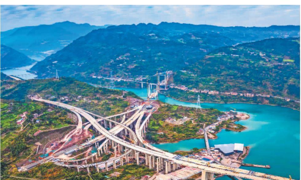
1月1日,四川省宜宾市屏山县新市镇,沿江高速宜金段杨柳坝互通工程现场,施工团队抢抓工期全力施工,确保项目如期完工。 曾三东摄(中经视觉)
