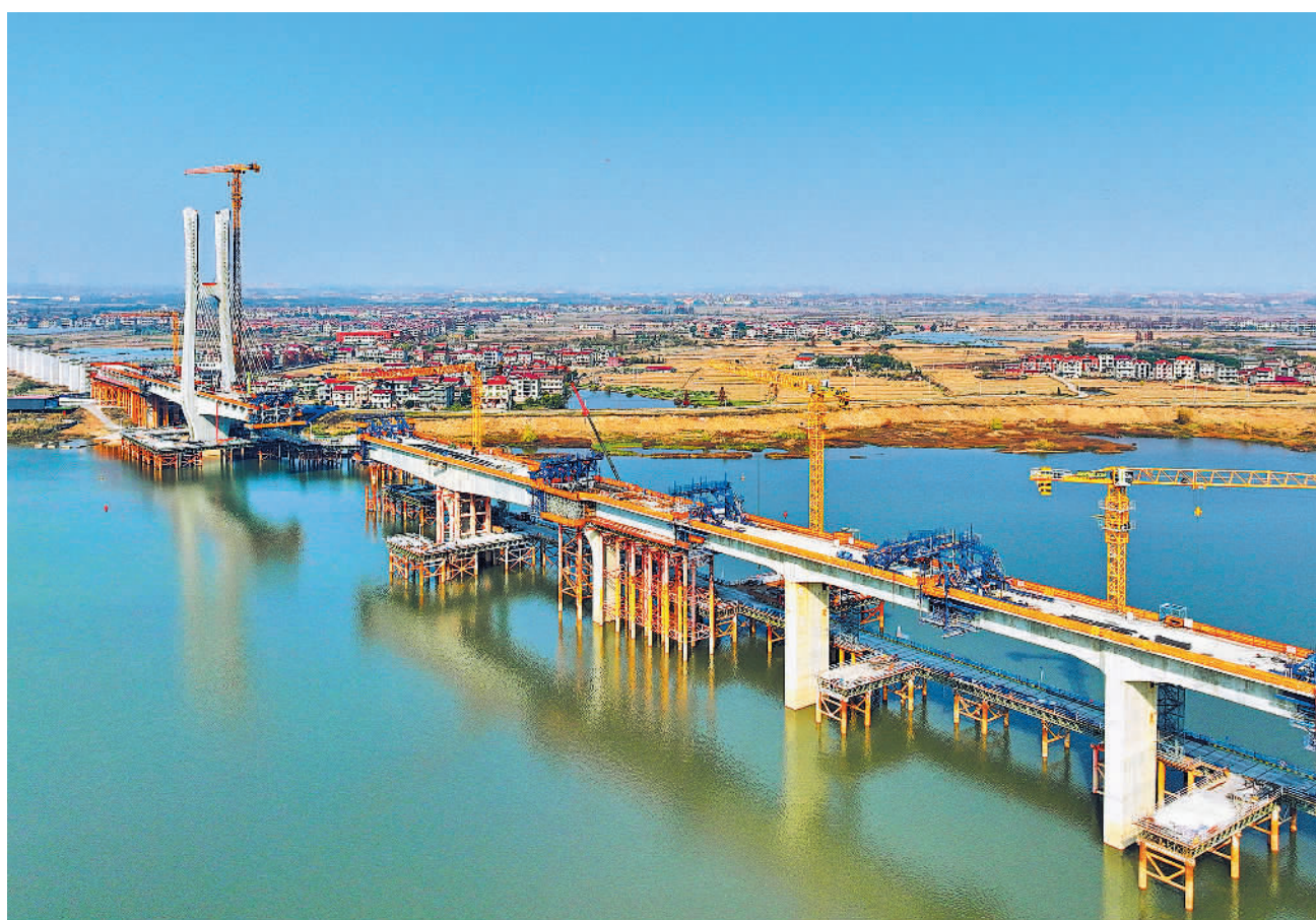
12月28日,江西省南昌扬子洲赣江公铁大桥南支主桥项目工地塔吊林立,建设有序进行。南昌扬子洲赣江公铁大桥是昌九高铁重点控制性桥梁工程。昌九高铁建成通车后,将推动江西进一步对接融入粤港澳大湾区,促进沿线经济社会高质量发展。(中经视觉)
