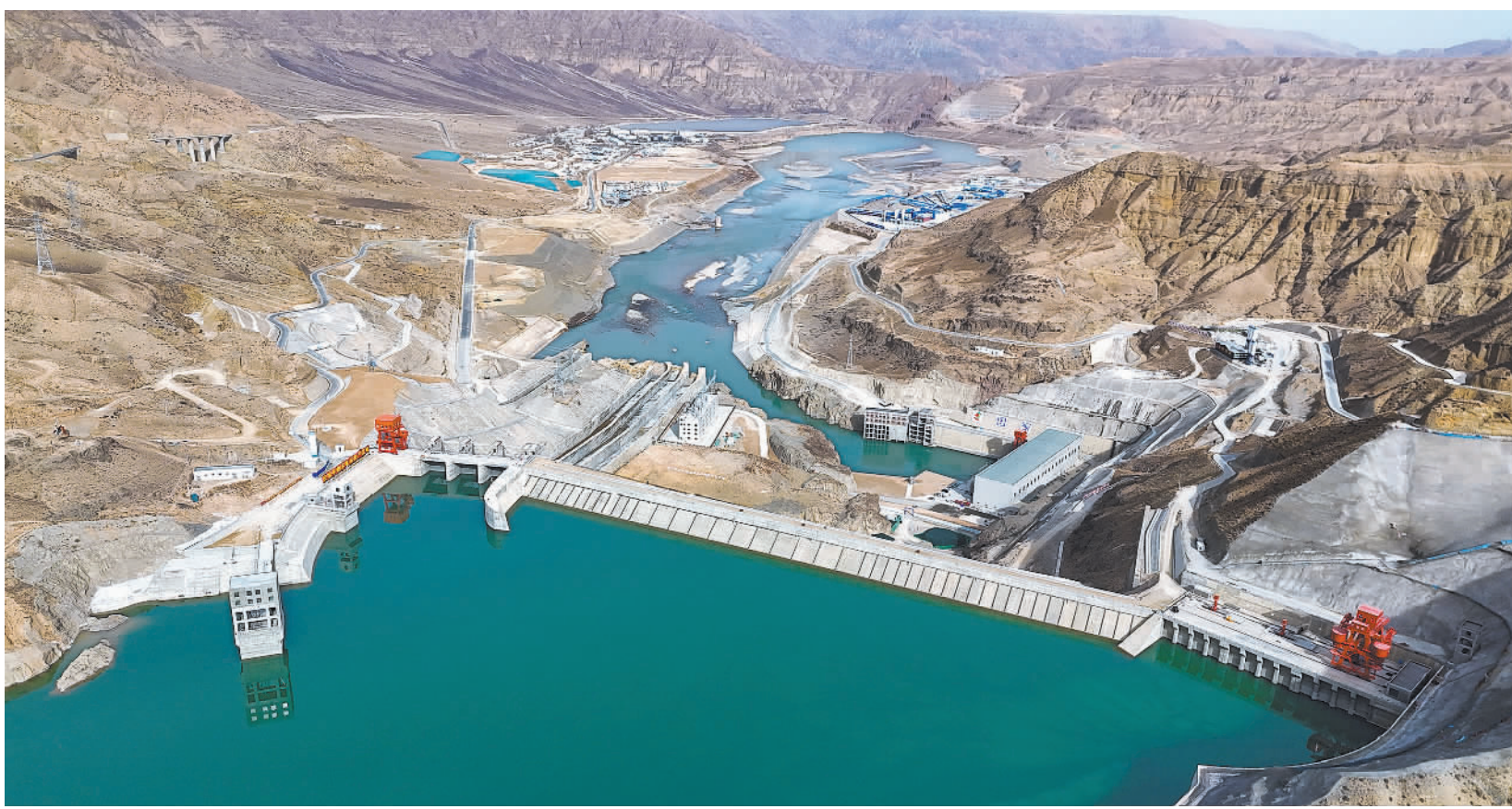
12月24日,位于青海省黄河上游的羊曲水电站最后一台(3号)机组通过72小时试运行正式并网发电,标志着羊曲水电站按期实现全容量投产发电目标。该站是国家规划建设的重点工程,在国内首创采用嵌固混凝土面板堆石坝新坝型,达到行业领先水平。这是当日拍摄的羊曲水电站。
