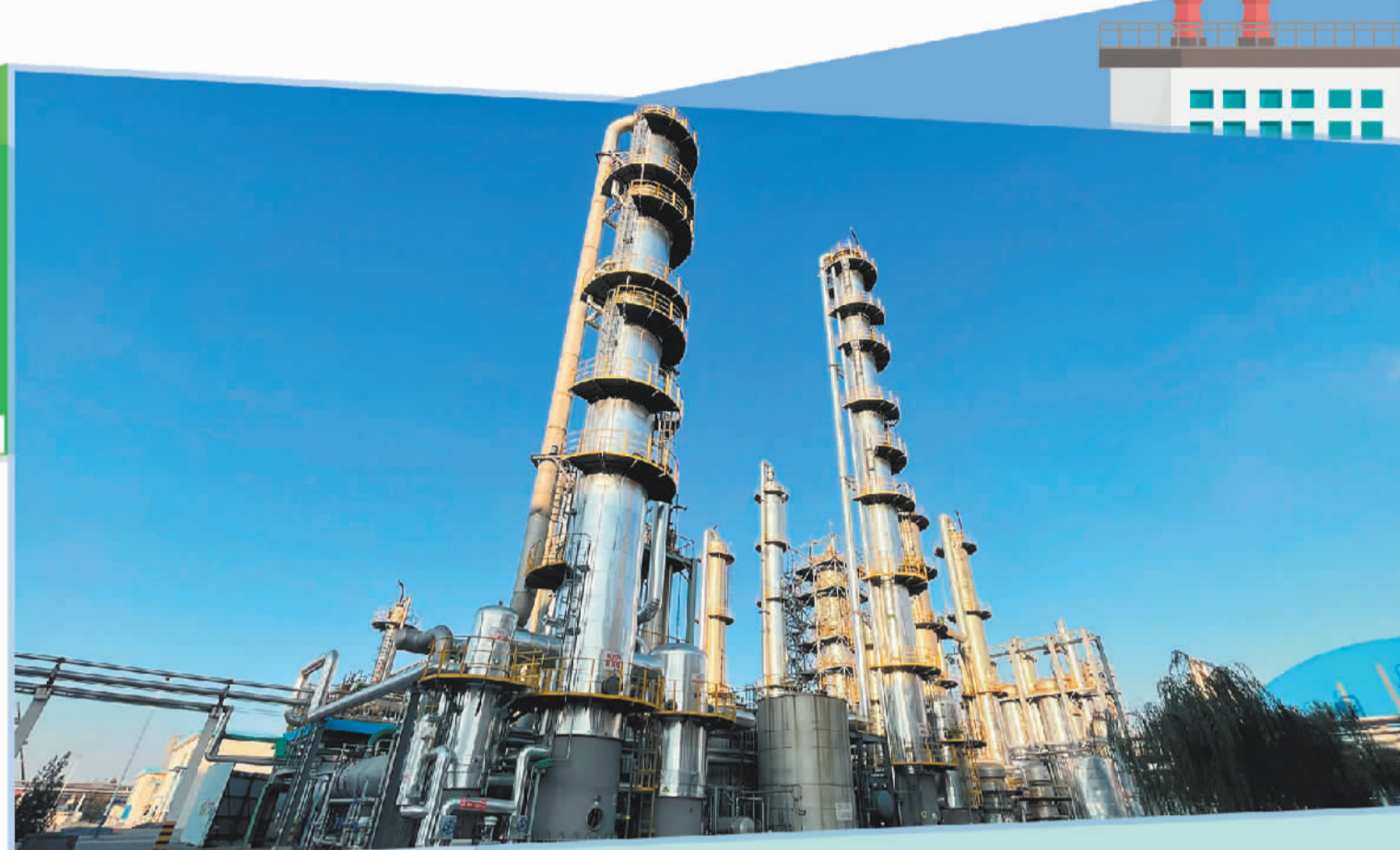
双欣环保公司厂区。
