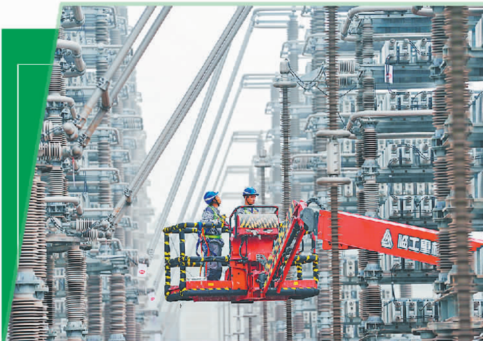
国网安徽电力检修人员对古泉换流站设备进行检修、维护。 郑贤列摄(新华社发)
