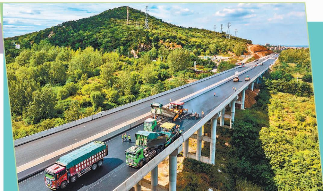
山东高速集团投资建设的日照港岚山港区疏港高速施工现场，工人正在进行路面摊铺。(资料图片)
