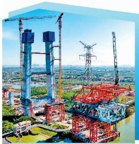
深江高铁洪沥水道公铁大桥首节段钢梁架现场。新华社记者 邓华摄
