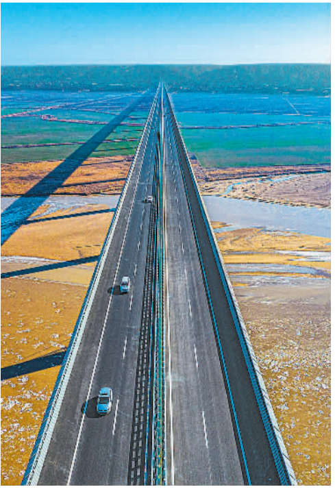
12月16日,山西省运城市长临黄河大桥正式通车。该工程是山西省高速公路网规划“四纵十五横三十三联”的重要组成部分,将有力促进黄河金三角经济协作区建设。
