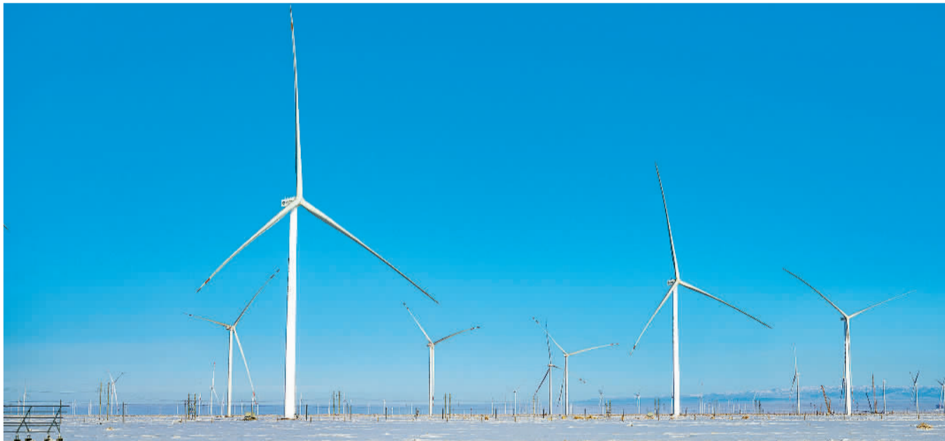
12月12日，新疆昌吉回族自治州木垒哈萨克自治县若君庙风电场250万千瓦风电项目现场。当日，该项目顺利并网发电，预计年发电量62.5亿千瓦时，可减少二氧化碳排放量约623万吨。
