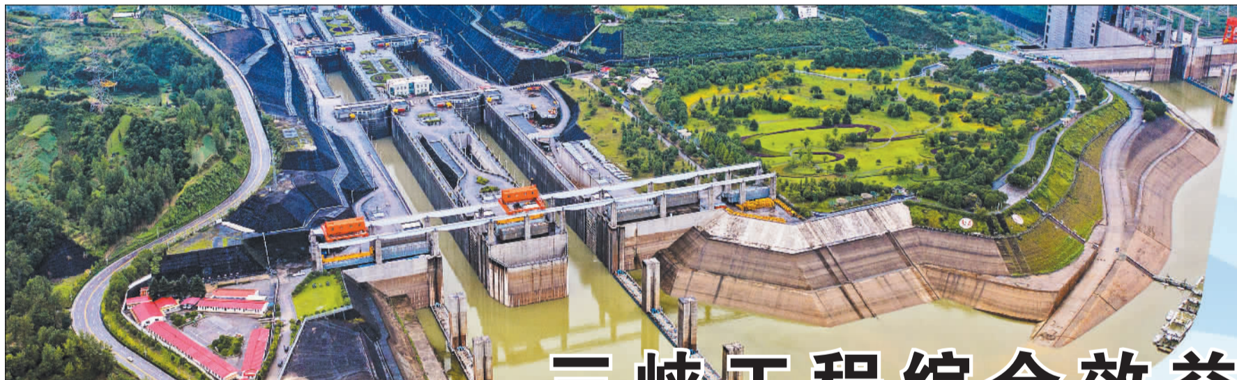
三峡双线五级船闸
