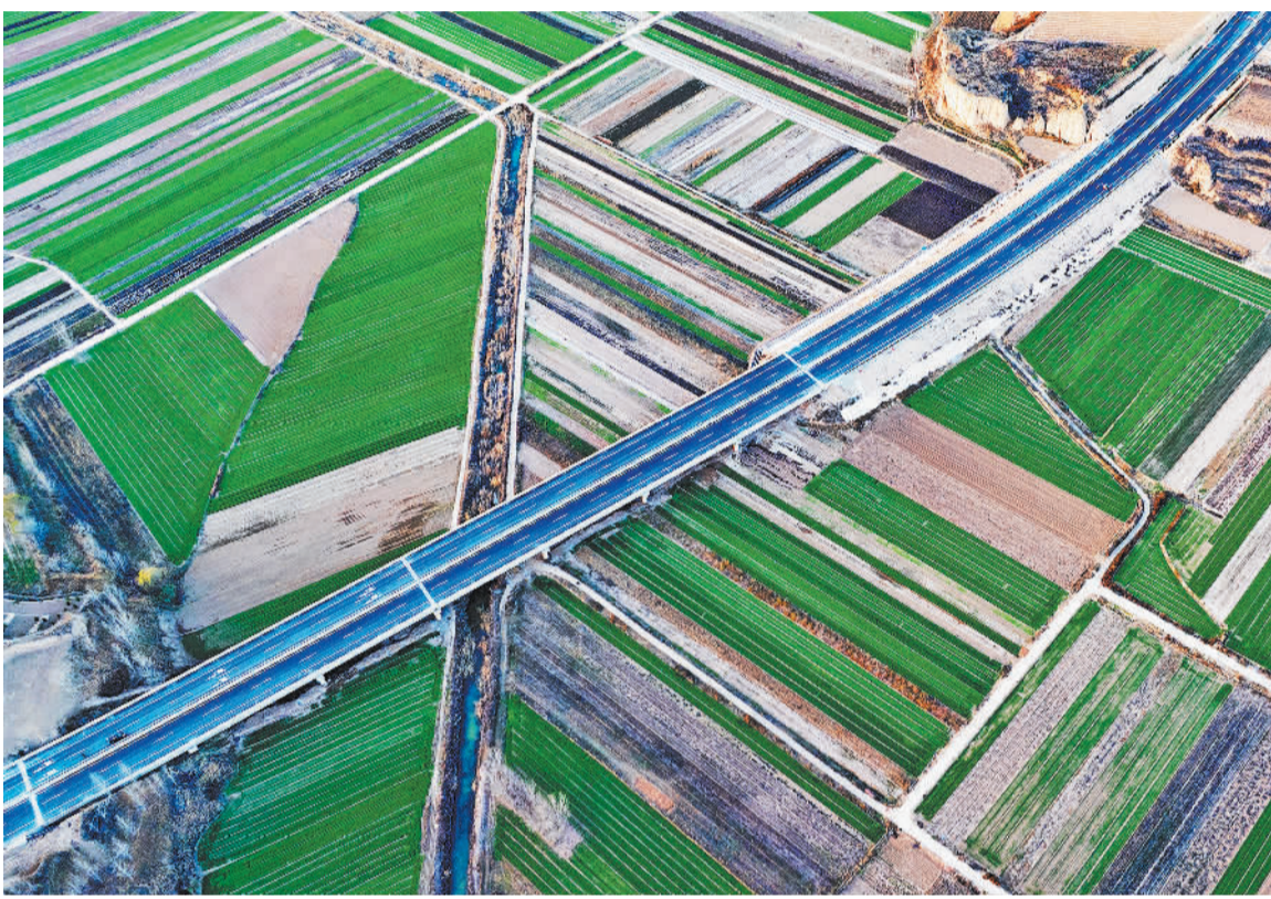
12月7日,在山西省临汾市曲沃县国道108项目北董互通附近拍摄的新建公路场景。当日,随着曲沃北董互通沥青摊铺结束,中交一公局集团国道108项目实现了襄汾—曲沃段主线全线贯通,为年底全线顺利通车奠定了良好基础。国道108项目建成后,将成为临汾市重要通道,对于激发区域经济发展活力具有重要意义。李现俊摄(中经视觉)
