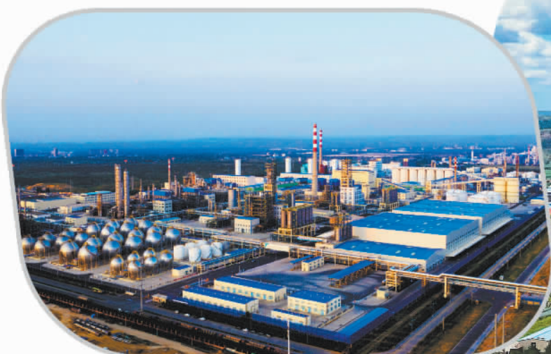
准格尔经济开发区久泰新材料公司厂区
