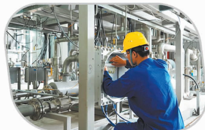
准格尔旗纳日松光伏制氢示范项目制氢厂区工作人员调试电解槽
