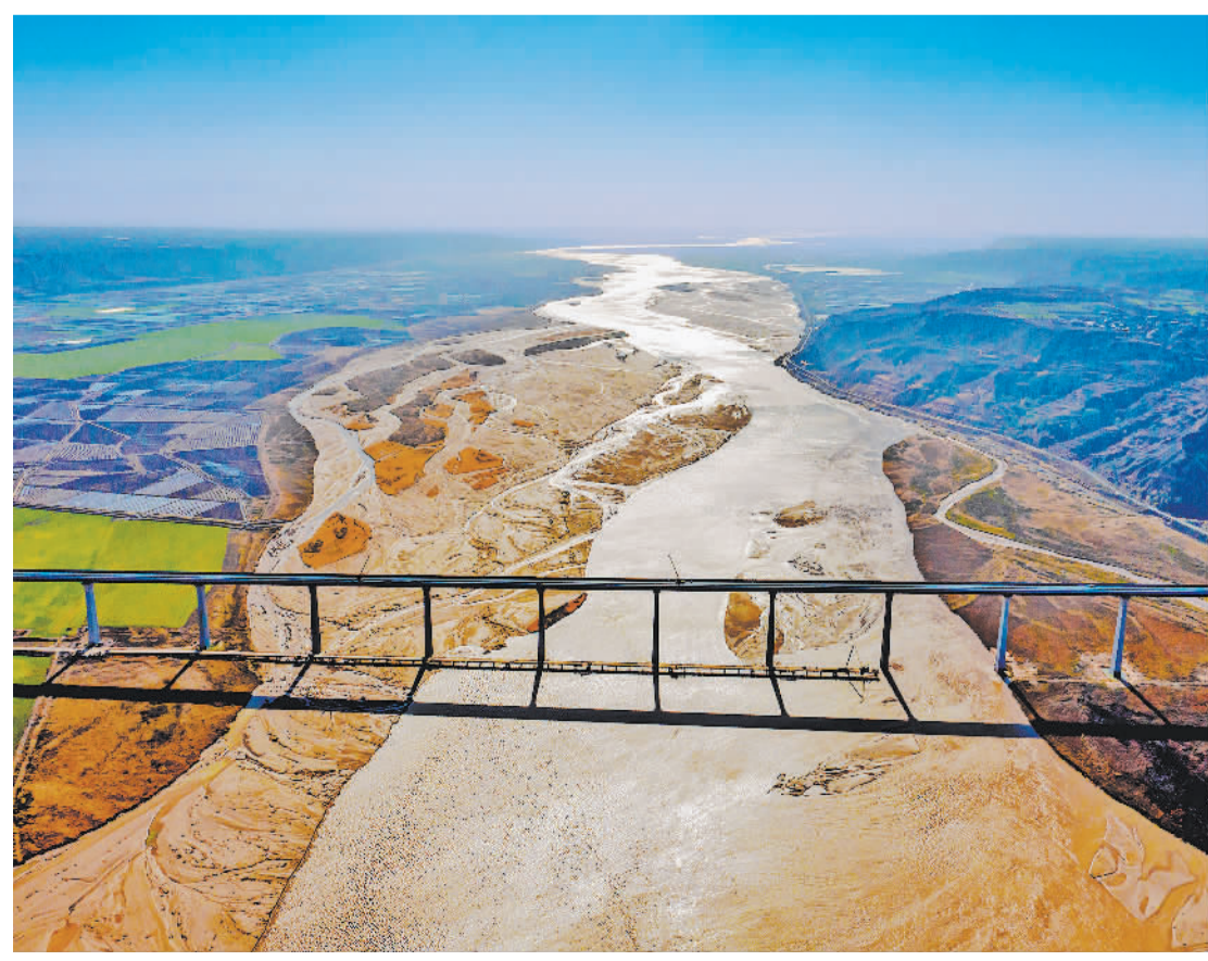
11月27日，山西省运城城市临猗黄河大桥及引线工程项目施工现场，施工人员在加紧施工。临猗黄河大桥及引线工程项目线路长达20.91公里，通车后将与陕西合阳至铜川高速公路顺接，加快推动晋南地区形成便捷智能、绿色安全、互联互通的综合交通网络。 闫鑫摄(中经视觉)
