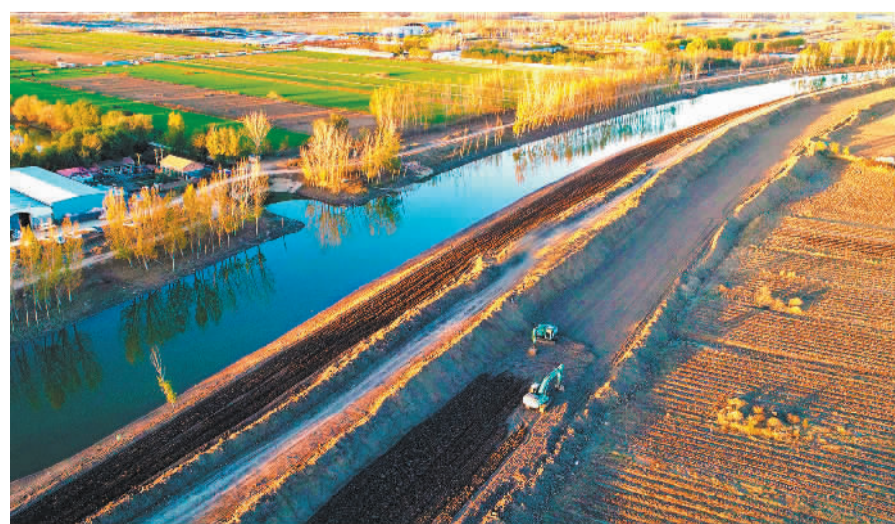
▼11月25日,中铁二十局员工在天津市子牙河施工现场加宽加高河堤。 曲志忠摄(中经视觉)
