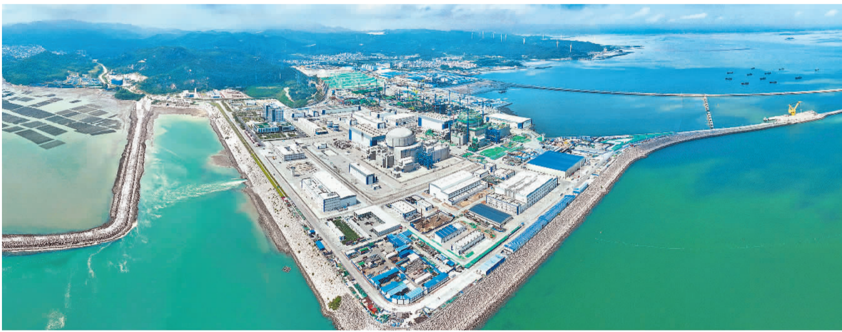
11月28日上午,我国具有完全自主知识产权的第三代核电技术——“华龙一号”漳州核电项目1号机组首次并网成功,开始向电网送电。这标志着中核集团“华龙一号”批量化建设取得重大进展。新华社记者 林善传摄
