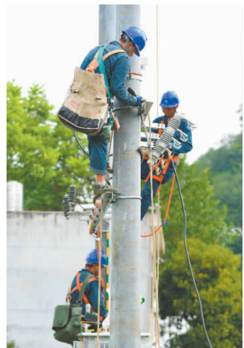
南方电网员工在贵州省毕节市大方县黄泥塘镇毕节供电局安装配变变压器
