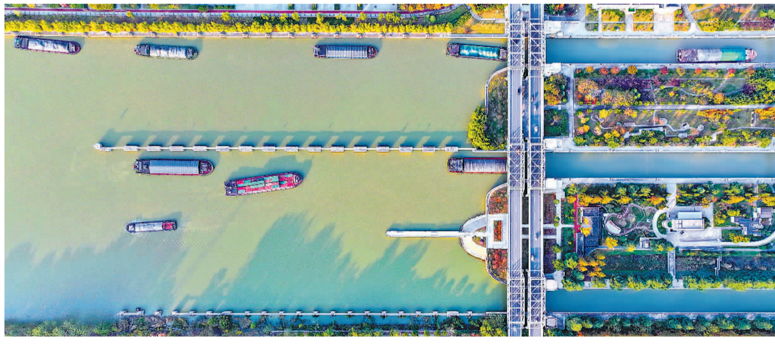
11月22日,货船有序通过江苏省宿迁市泗阳船闸。初冬时节,京杭大运河泗阳段运输钢铁、肥料、煤炭、建材等各类物资的船舶往返穿梭,保障运河沿岸生产生活需求。
